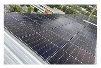
D'une puissance de 195 kWc, la centrale de GreEn-ER produira suffisamment d'énergie pour fournir entre 10 et 15% des besoins du bâtiment (23 000 m² et 2 000 occupants), et réduire d'autant la facture énergétique des lieux. L'excédent produit durant les week-ends et les vacances scolaires servira à alimenter les talons de consommation\*\* des autres bâtiments de Grenoble INP - UGA situés à proximité (sites grenoblois de Minatec et de Viallet.)
